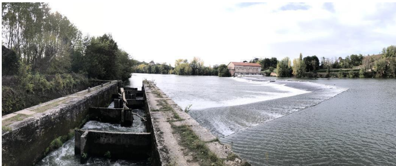
Illustration 15 : Vue d'ensemble la centrale hydroélectrique de Sainte-Livrade
