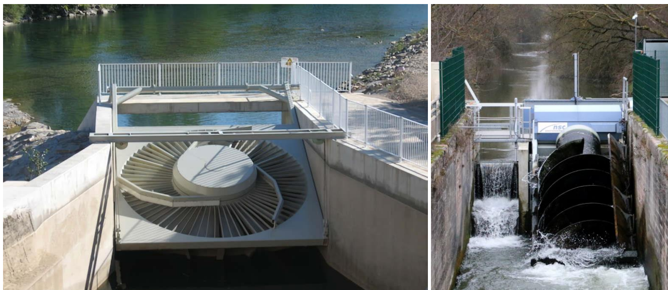
Illustration 1 : A gauche, turbine VLH (source : MJ2) à gauche - Vis hydrodynamique (source : DNA) à droite
