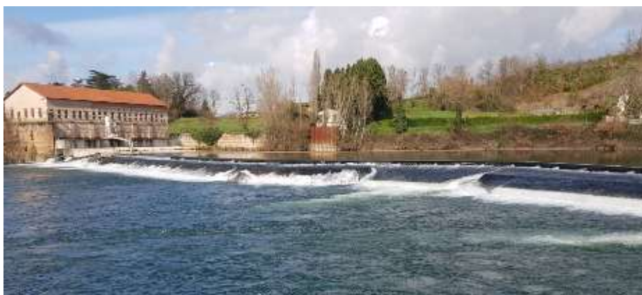
Photo 1 : Vue du seuil à partir de la rive gauche.
