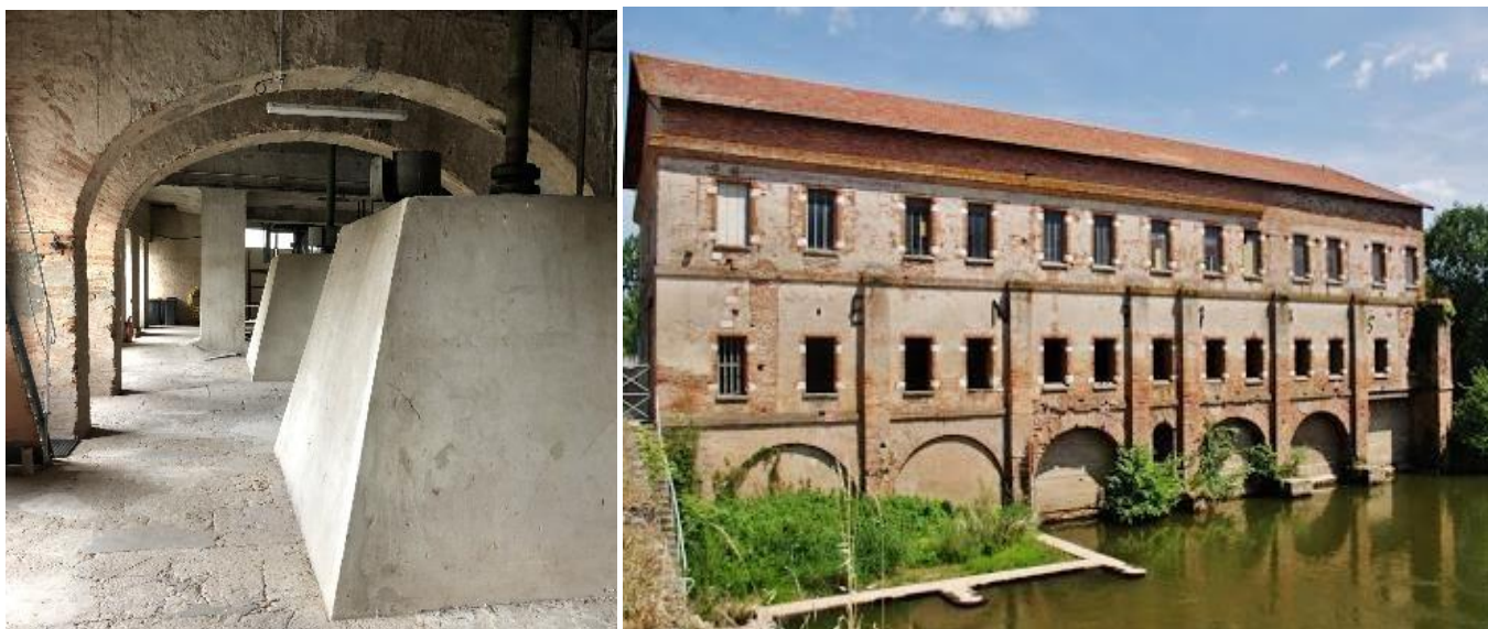
Illustration 1 : Photos de la centrale hydroélectrique de Sainte-Livrade
