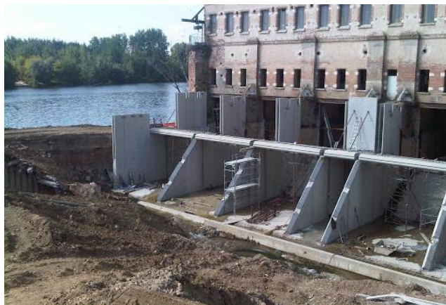
Illustration 8 : Photos de la prise d'eau de Sainte-Livrade lors des travaux de 2009
