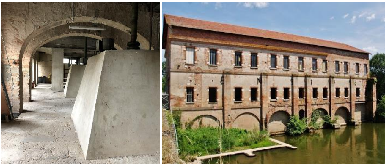
Illustration 4 : Photos de la centrale hydroélectrique de Sainte-Livrade
