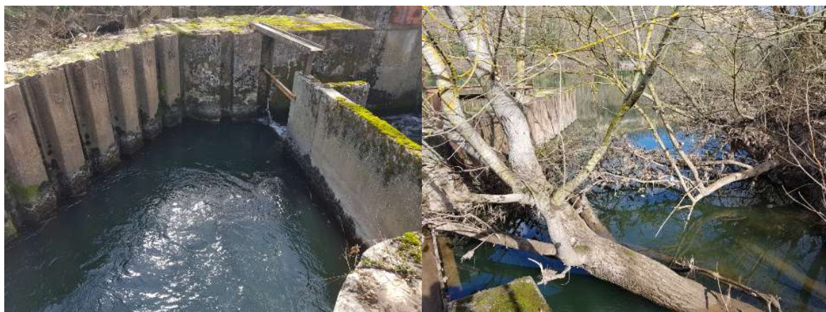
Photos 8 et 9 : Vues de la cloison amont à supprimer et l'emplacement du futur bassin d'entrée de la passe.
