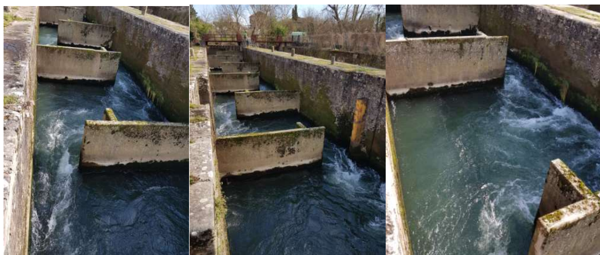
Photos 3, 4 et 5 : Vues de la passe à bassins à 3.2 m 3 /s.
