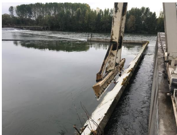
Illustration 4 : Prise d'eau avec dégrilleur
