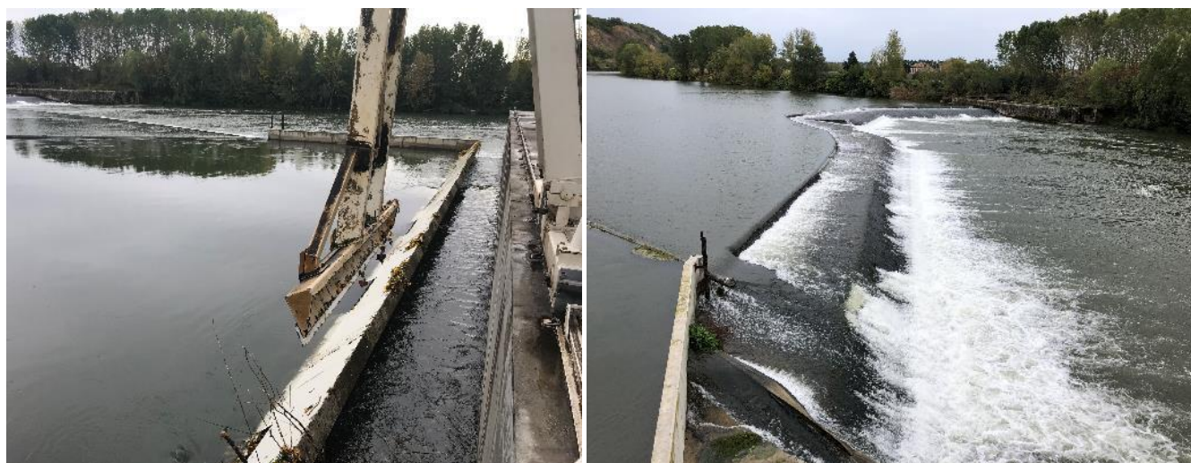
Illustration 5 : Prise d'eau avec dégrilleur
