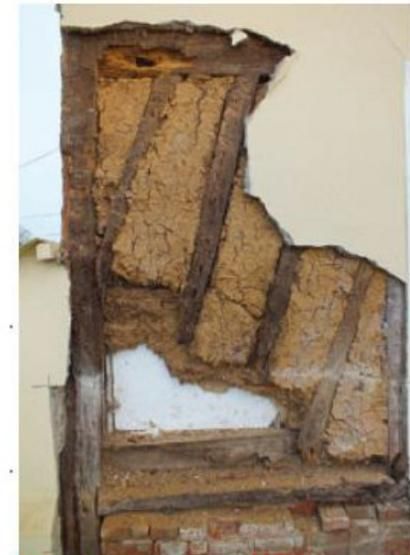
1) Un mur en pan de bois, victime d'un mauvais usage de matériaux contemporains (Polystyrène et enduit ciment)
