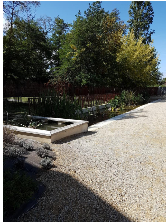
Bassin de remise en température avant rejet au Canal
